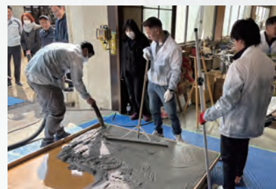
生コン打設中
