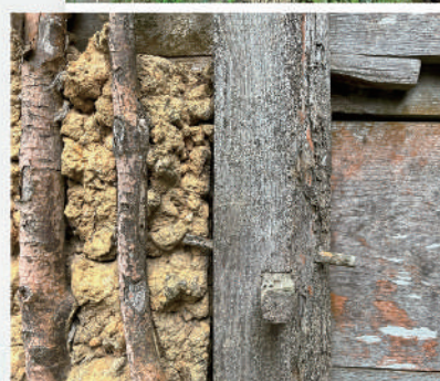
図3 岡山県の土蔵の壁体断面図(木造軸組+横板落とし込み+小舞下地)
