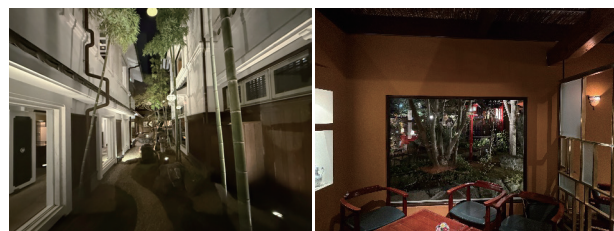
写真1 本しっくいの外壁 写真2 土壁の内壁と本漆喰
