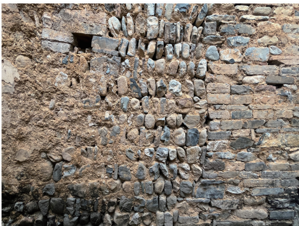
古い建物の石積み壁の様子
