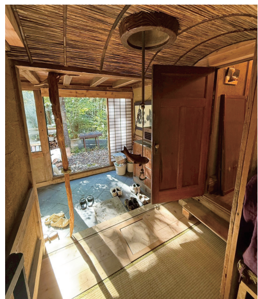
写真2 土壁と共に減った畳や土間
