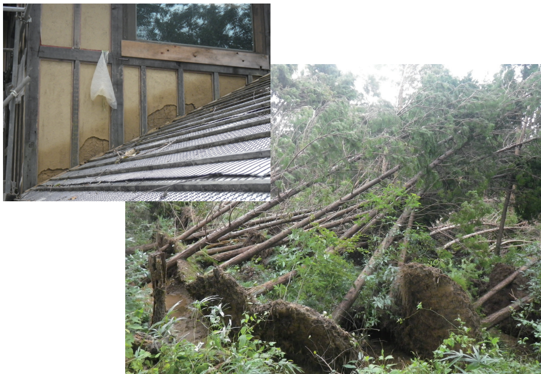
写真1 平成25年台風第26号の被害
