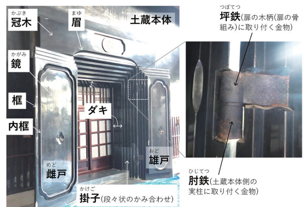
図1 土蔵の出入口の各部構成(両開き戸の場合) (Vol.5にも掲載)
