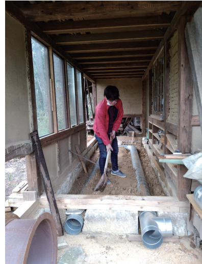
写真5 オンドル形式の薪ストーブの施工
