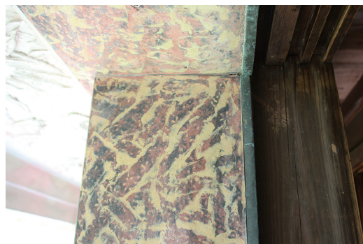
写真7 漆喰擬石塗仕上げ
