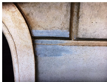
写真-4 南面窓付近
