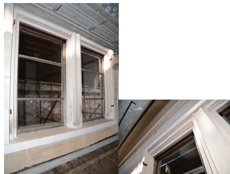
写真-8 漆喰蛇腹窓詳細 二連窓の方立柱部分はアール状に塗り廻している
