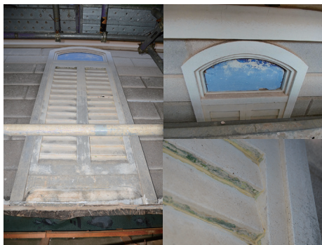
写真-2 擬鍔戸窓。全てが砂漆喰上げで、入隅部分で淡緑色と焦げ茶色の着色が見られ、上部には半円形擬窓がある。漆喰枠を三重に施し、洋風意匠を強調している
