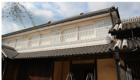
写真-3 南面（正面）修理工事完了
