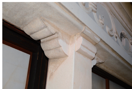
写真-6 柱・頭部漆喰装飾仕上げ
