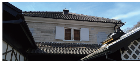
写真-7 東面漆喰蛇腹窓修理工事完了
