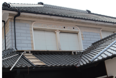
写真-5 北面龍の間・次の間外壁修理工事中
