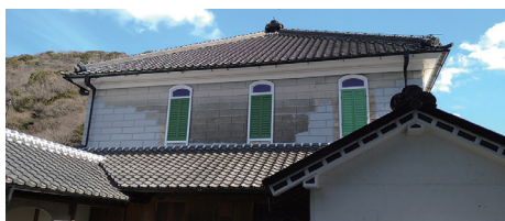
写真-1 西面外壁修理工事完了
