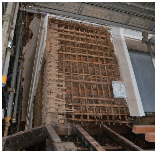
写真－2 当初の壁下地と過去の補修下地（北面） 柱部分の割竹は後年に補修された部分
