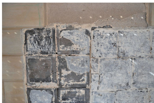
写真－4 当初の瓦張り状態（東面）
