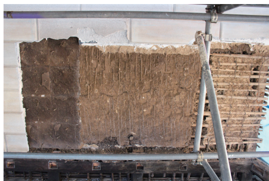
写真－3 塗層は荒壁と中塗壁の2回塗りとなっている。右側は過去に瓦・下地から補修された範囲（東面）で細かく割った竹を使用している
