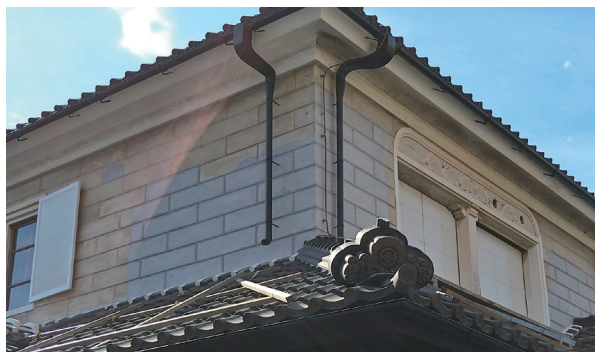
写真－1 東北面修理中
