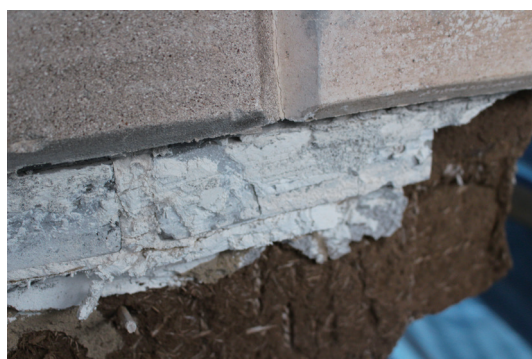
写真－6 瓦面上層面の砂漆喰が接着するように、生漆喰を塗っている。しかし、目地部分は生漆喰の上には砂漆喰が見られない。よって斜めに削った両しのぎ状の目地棒を使用したものと考えられる
