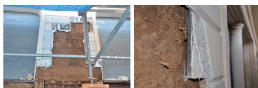
写真－5 当初壁で荒壁・瓦・漆喰塗層詳細（南面） 当初壁は荒壁面に中塗土を塗り重ねた後に、瓦を竹釘で止めている
