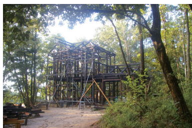
写真 思い出の足場と棟上げ後の全景
