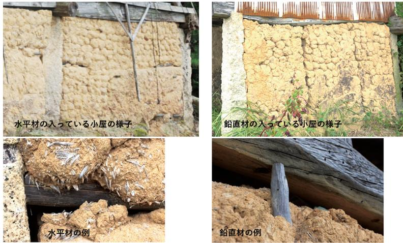
図6 壁体内の水平材・垂直材の例
