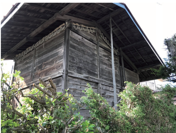
原村の板倉の例。柱があり横板落とし込みの板倉であることがわかる。よく見ると、板倉の屋根根（二重屋根の下部）に土が塗り付けてあり、その土の層に挿入された壺縄が垂れ下がっている。これは、後に壁土の塗り付けを想定してのことだと予想される。
