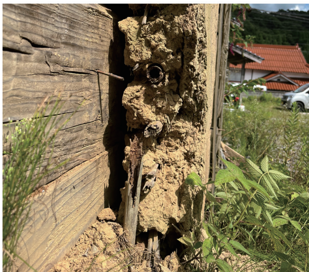
井籠組の板壁と土壁の様子
