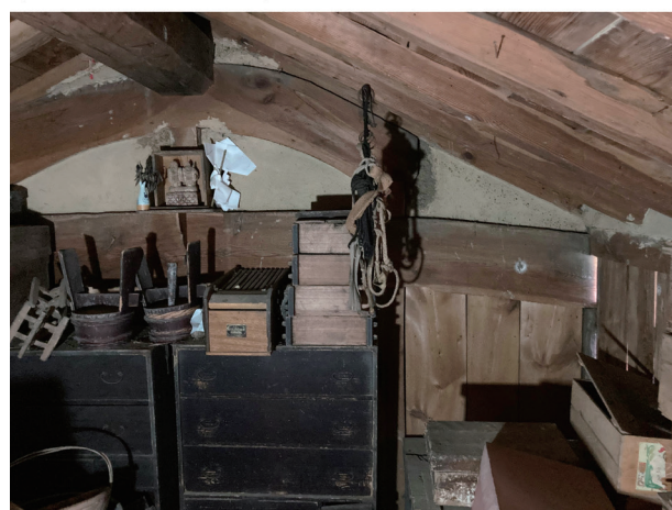
内観の様子。壁は1階は落とし込み板（横板）、2階は縦板張りになっている。小屋組は一般的な木造軸組の土蔵に見られる牛梁および登り梁を用いる方法である。
