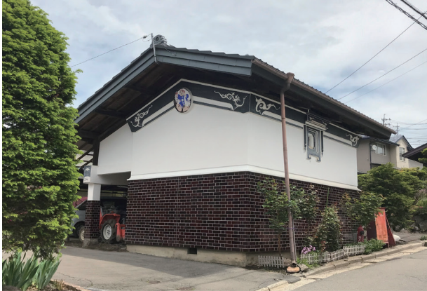
茅野市の土蔵の例。漆喰で仕上げられた外観からは木造構法の種別を伺い知ることはできないが、周辺の地域では井籠組や落とし込み板倉などの板壁を下地として壁土を塗り重ねた土蔵が多い。
