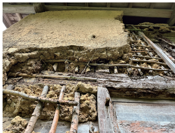
木造軸組・板壁と土壁の様子
