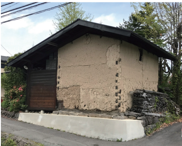
茅野市の土蔵の例。土壁が剥がれた箇所から厚板の断面が見えており、井籠組である様子が伺える。
