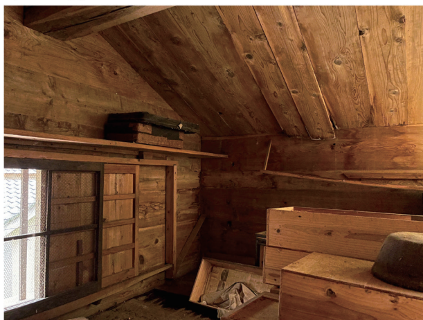
内観の様子。壁は井籠組であり、屋根は牛梁と桁に厚板をかけ渡してある。
