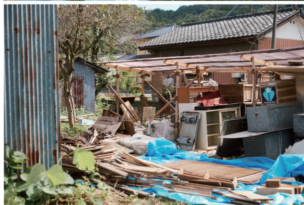
図3 残置物の運び出し
