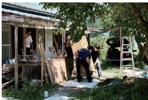
図2 床板を外して床下の状況を調査
