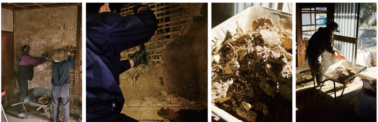
(d) 仕上げを剥がした後の土壁解体の様子
