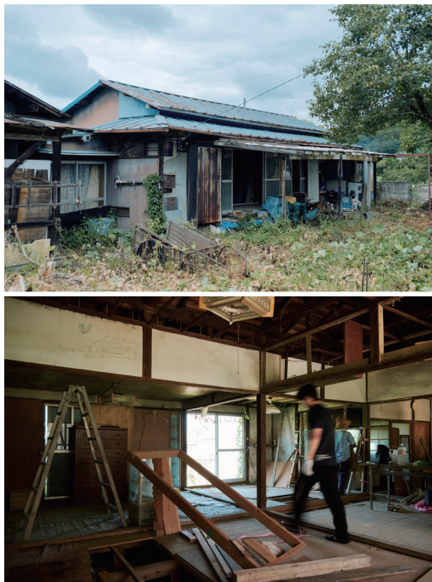
図1 リノベーションする建築の外観と内観
