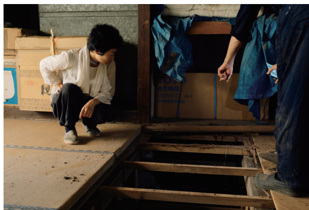
図2 床板を外して床下の状況を調査
