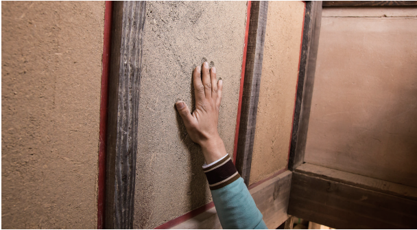
写真2 土壁のバッテリーチャージャー
