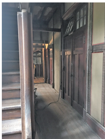
写真 階段下のウグイス張りの床
