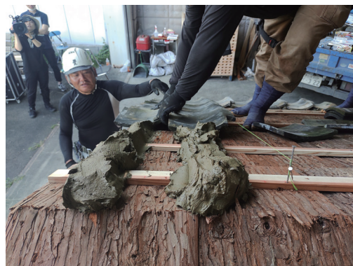
写真 大正時代の土葺き瓦屋根の再現
