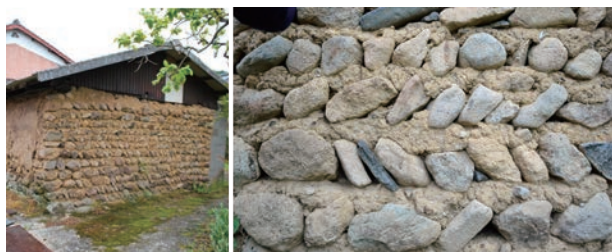
図4 石を斜め積みする壁（大分県の例）
