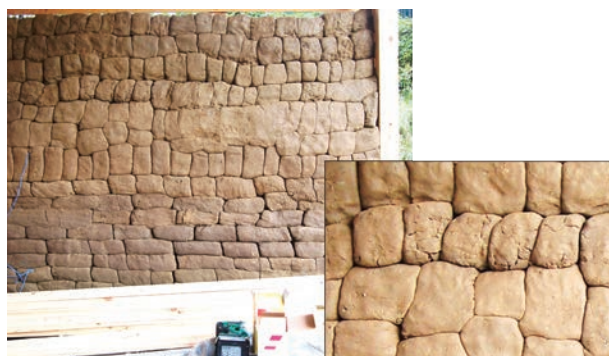
図6 学生たちとセルフビルドした土積み壁
