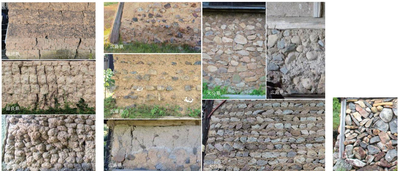
団子状に成形した土を積む場合や、成形せずに湿った土を積み上げる場合などがある。土積み壁 ← 土積み壁と石積み壁の中間的な、土と石を積んだ壁。土を主体として石が混ざったような場合や、石が主体で土が目地材のように用いられる場合などがある。 → 石積み壁
