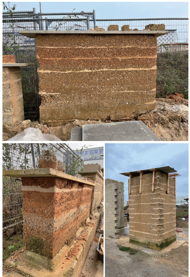
写真3 ワークショップ等で作られた版築壁の様子
