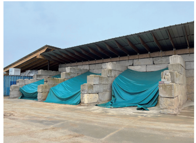
すでに3〜4回使用された履歴のあるコンクリートブロックを用いて、レゴブロックのように組み合わせ、資材置き場を作っている。再組立て可能なだけでなく、拡張可能なつくり方となっている。
