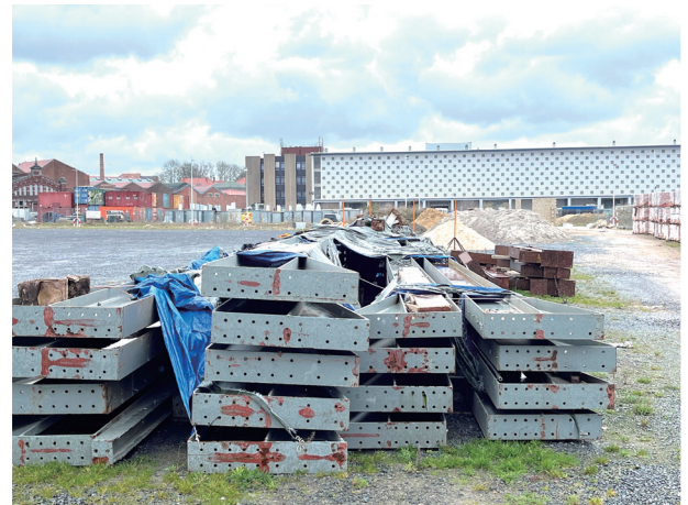
写真5 解体材リユースのための仮置きの様子
