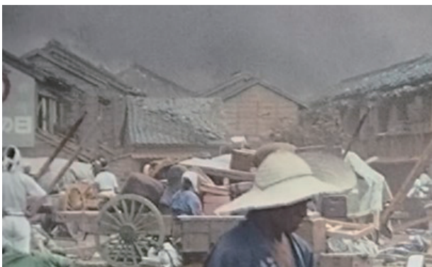
写真1 地震により瓦屋根が脱落した様子
