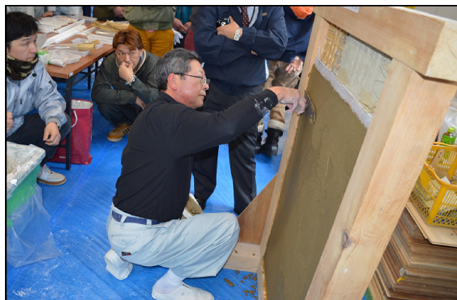
土壁の中塗り工法の実演
