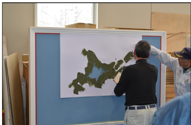
北海道の形をモチーフにした土壁の中塗り工法の実演
