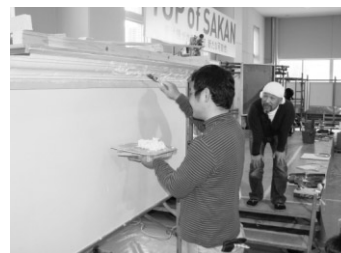
現場引き蛇腹の施工を実演しています
