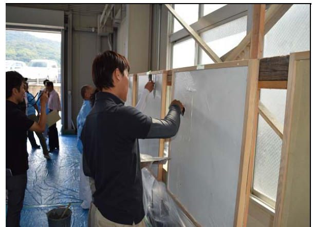
伝統工法の漆喰塗り
