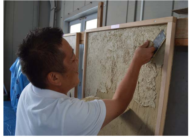
伝統工法の5分壁塗り
