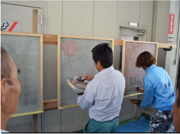
現代工法のペーパーウォール(水のいらない洗い出し工法)
