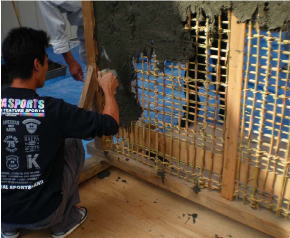
①土蔵の解体土を使用した粘性が強い荒壁土の塗り作業。
