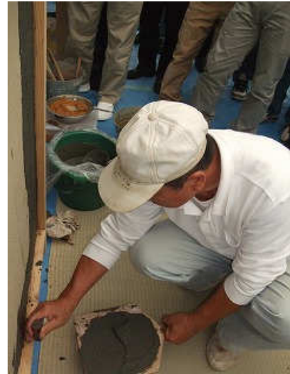
浅原指導員による漆喰壁工法実演
