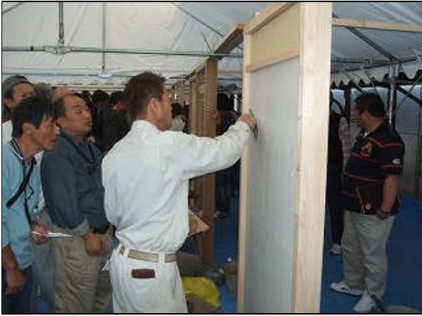
山本指導員によるボード下地大津壁仕上げ工法
