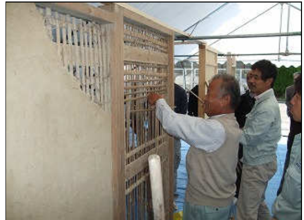
佐伯指導員による小舞壁工法
