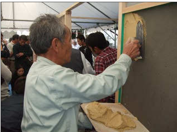
村中指導員による色モルタル掻き落とし工法
