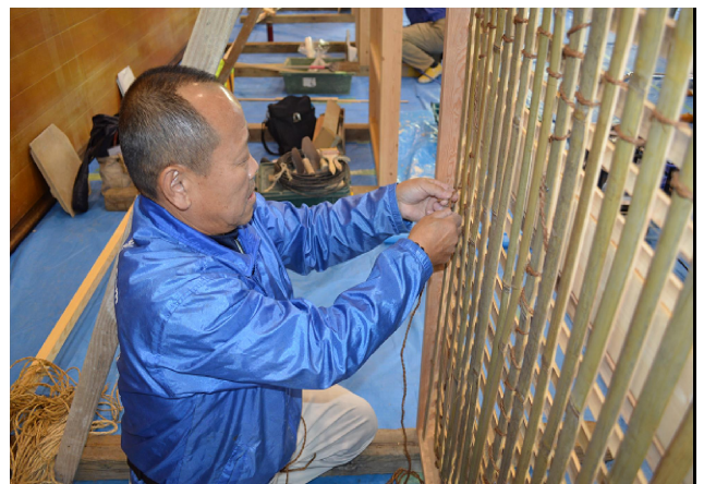
小舞壁の掻き縄を編んでいる様子
