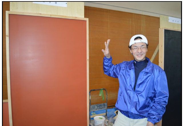
完成した光沢のある磨き壁
