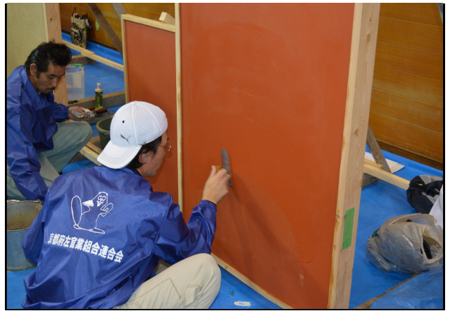
磨き壁を施工している様子
