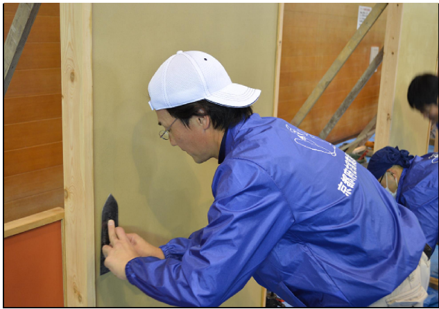
下地を施工する様子
