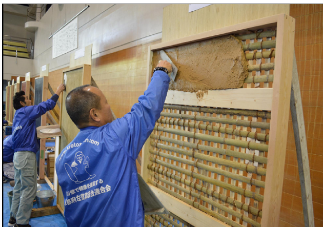
荒壁を施工している様子
