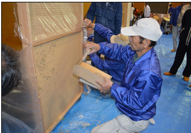
ドイツ壁の施工している様子
