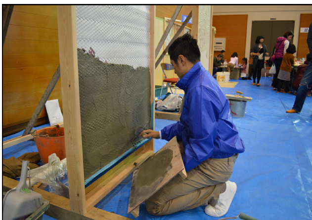
通気工法の施工を行う指導員
