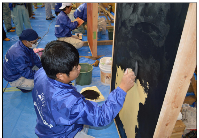
大津壁を施工している様子
