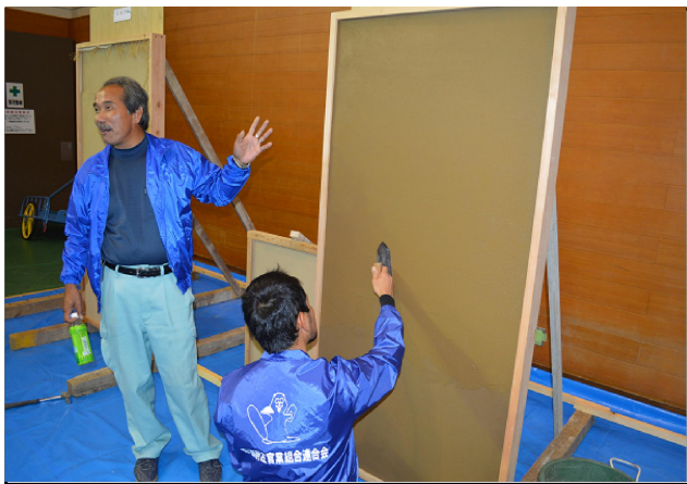
水捏ねを施工している様子を説明する指導員
