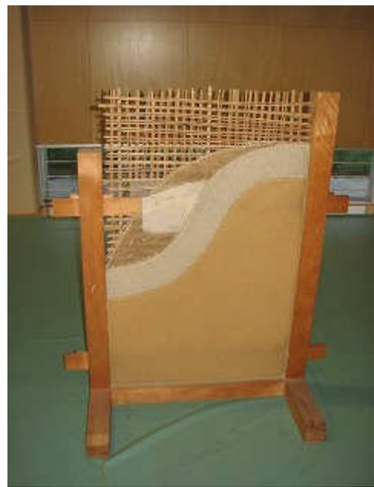
土壁(真壁)の下地～中塗り模型
